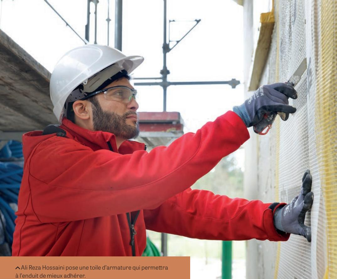
▲ Ali Reza Hossaini pose une toile d'armature qui permettra à l'enduit de mieux adhérer.
