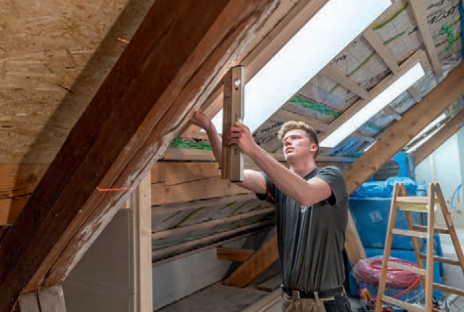
◀ Mit Laserlot und Wasserwaage bestimmt Sven Bevern die Position von Pfosten, die eine Wand unterteilen.
