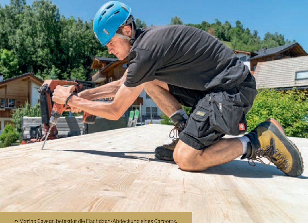
^ Marino Cavegn befestigt die Flachdach-Abdeckung eines Carports.
