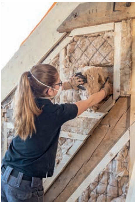
> Renovierungen Zimmermänner und Zimmerinnen erneuern bestehende Gebäude-teile – von den morschen Dachbalken eines Chalets bis zur Holzfassade am historischen Altbau.
