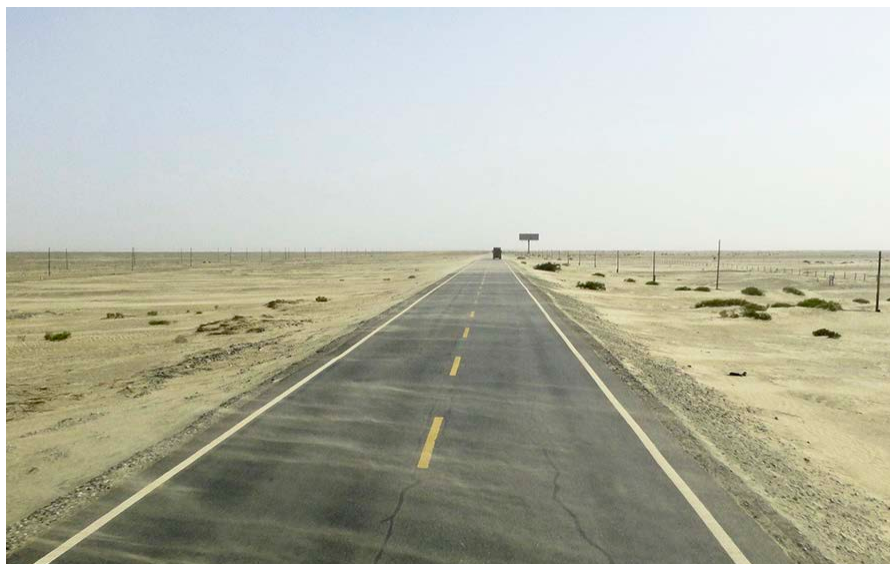
Schnurgerader Fortschritt: Die neue Seidenstrasse nimmt keine Rücksicht auf die Bedürfnisse der Menschen, die hier leben. Highway 218, Xinjiang, China.
