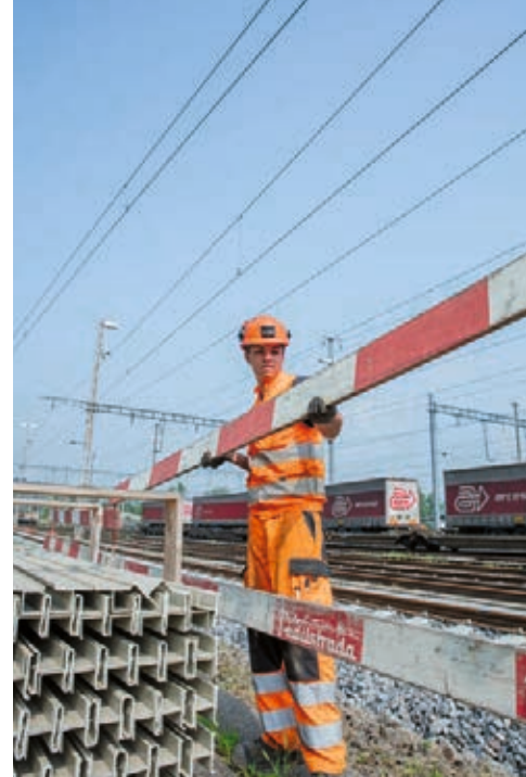
^ Avant d'entamer les travaux sur les rails, le constructeur de voies ferrées sécurise le chantier à l'aide de clôtures mobiles.
