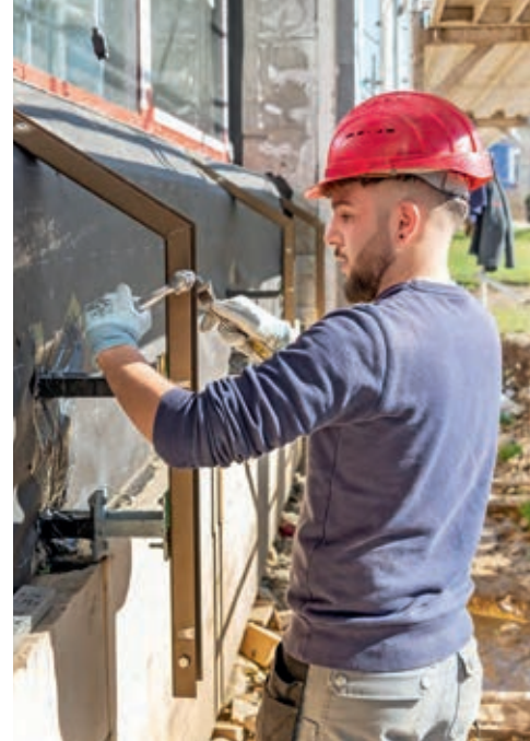
▲ La sous-construction doit être montée minutieusement.
