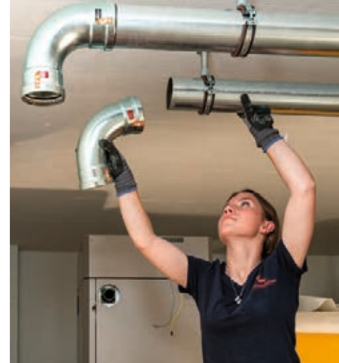
^ Die Lernende montiert etwas dickere Heizungsrohre, um die Sauna und den Pool zusätzlich beheizen zu können.
