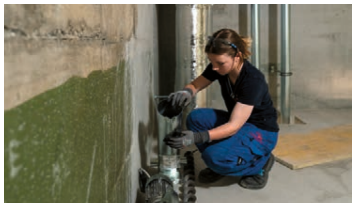
^ Auf der Baustelle setzt Angelina Wildhaber die Teile zusammen, die sie in der Werkstatt vorbereitet hat.
