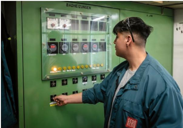
**▲ Réglér les machines** Les électroplastiques et les assistants en traitement de surface règlent par exemple la température des bains avant d'y plonger les pièces. Celle-ci influence l'aspect final du dépôt métallique.
