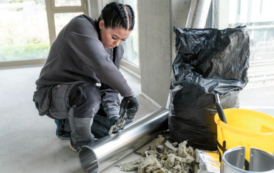
◀ À l'aide d'une cisaille, Kyla Häcki découpe une ouverture destinée à suspendre une conduite.
