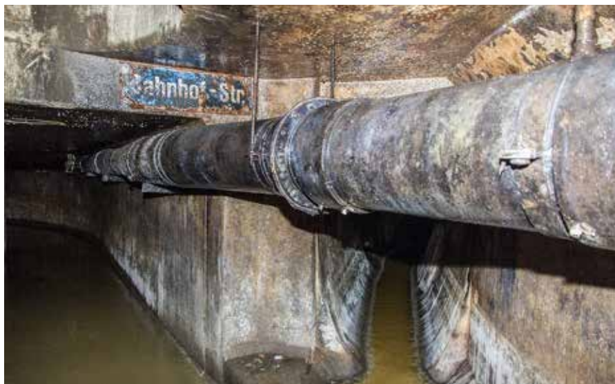
Trennkanalisation unter der Bahnhofstrasse in Zürich: Die Kanäle transportieren Schmutzwasser zur Kläranlage. Über das Rohr wird Regenwasser abgeführt.
