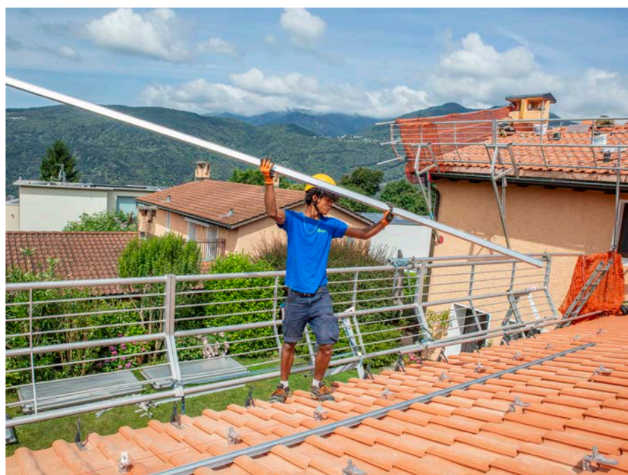
^ Une bonne condition physique est nécessaire pour déplacer les rails de fixation sur les toits.
