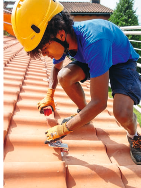
^ Samuel Stockburger utilise un fil rouge pour que les crochets soient parfaitement alignés.
